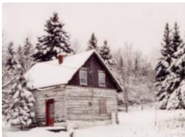
Bureau de poste, 1922 (Source : Municipalité de Duhamel)
