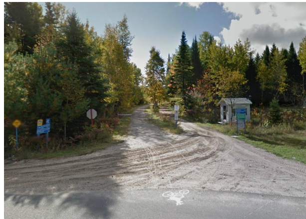
Accès à la piste multifonctionnelle à la sortie nord du village, 2012
